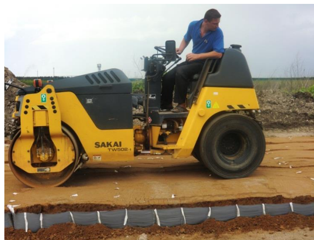
Фото 9 Уплотнение грунта в многосекционном «ГеоФРАМ» ручной трамбовкой и виброкатком.
