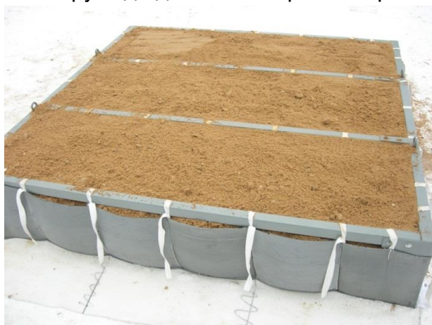
Фото 6. Засыпка многосекционного «ГеоФРАМ» грунтом при помощи экскаватора
