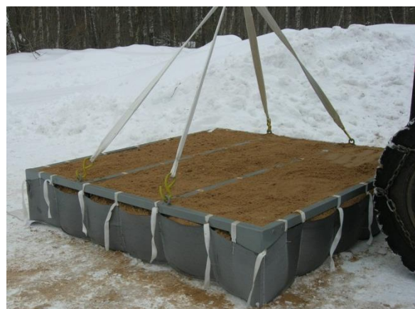
Фото 7 Выдергивание каркаса из засыпанной грунтом геоблочки «ГеоФРАМ».
