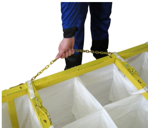
Фото 7 Выдергивание рамы из засыпанной грунтом геоболочки «ГеоФРАМ».
