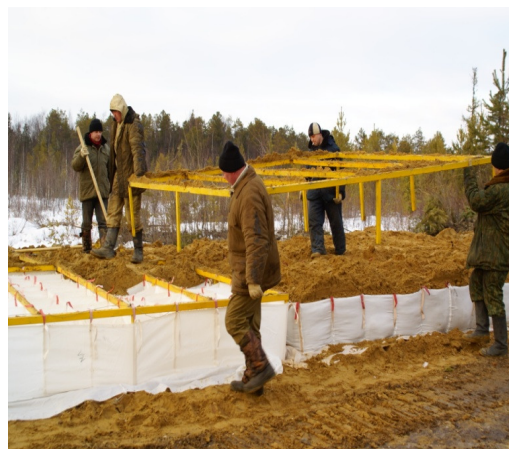
Фото 7 Выдергивание рамы из засыпанной грунтом геоболочки «ГеоФРАМ».
