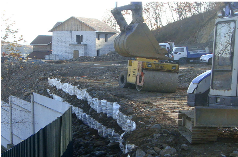
Фото 4. Строительство подпорной стены-дороги на склоне сопки в г. Находка.
