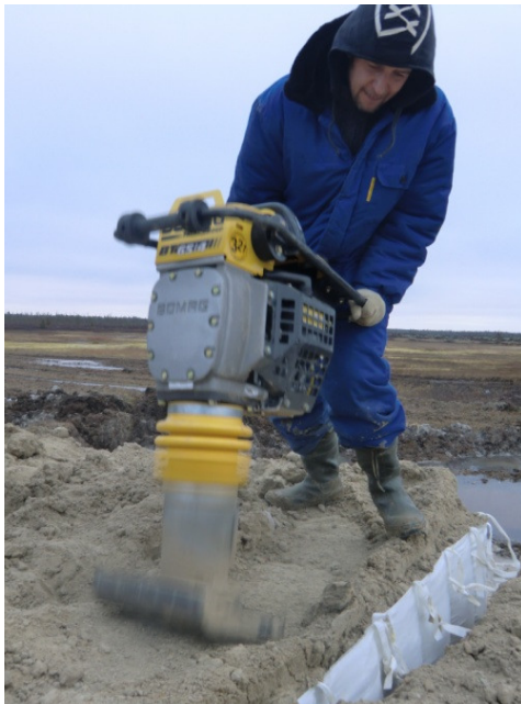
Фото 9 Уплотнение грунта в многосекционном «ГеоФРАМ» ручной трамбовкой и виброкатком.
