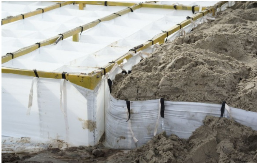
Фото 8 Связывание заполненных геоболочек «ГеоФРАМ» с незаполненными.
