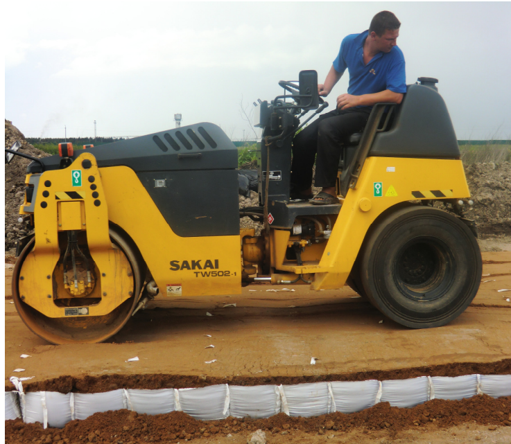
Фото 9 Уплотнение грунта в многосекционном «ГеоФРАМ» ручной трамбовкой и виброкатком.
