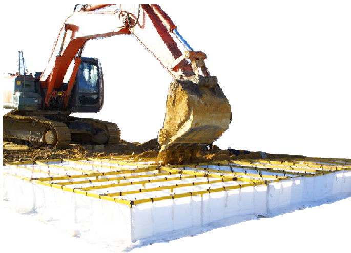
Фото 6. Засыпка многосекционного «ГеоФРАМ» грунтом при помощи экскаватора
