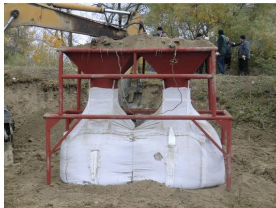
**Рис. 1.** Заполнение геоконтейнеров ГеоБ3Г при помощи загрузочного бункера
