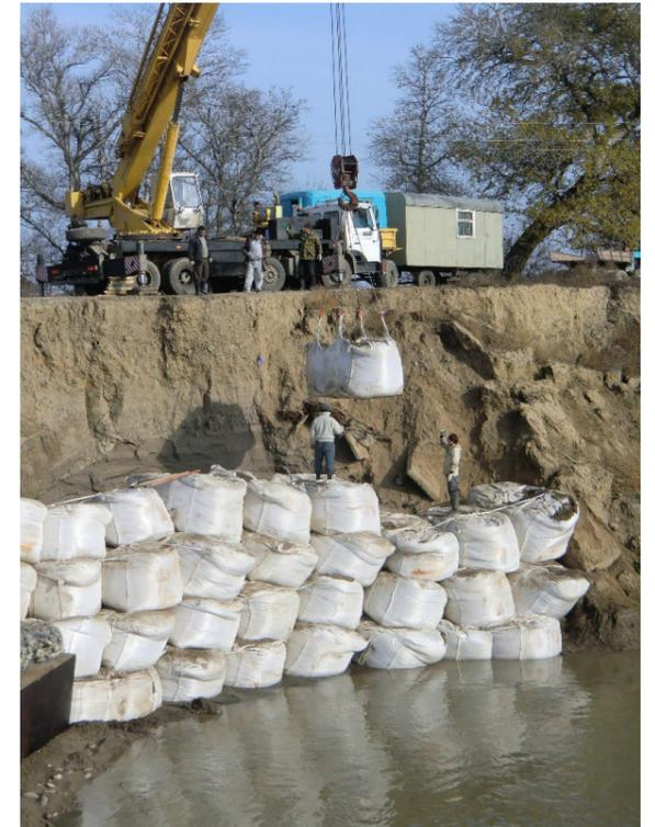
**Рис. 3.** Монтаж конструкции укрепления берега
