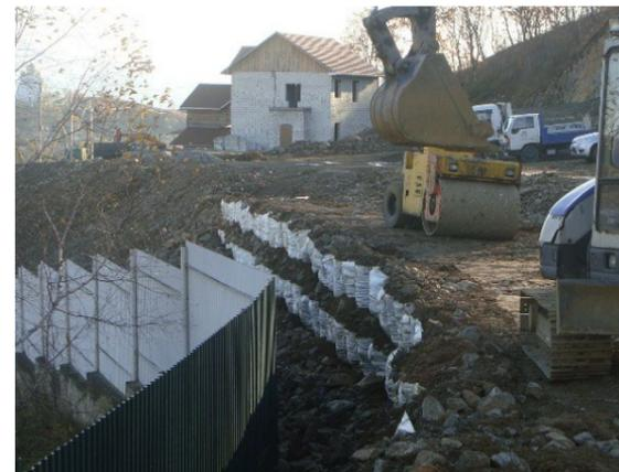
Рис. 6. Устройство выравнивающего слоя на поверхности подпорной стенки
